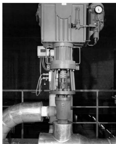
Mindestmengenregelventil ZK 213 mit elektrohydraulischem Kompaktantrieb
